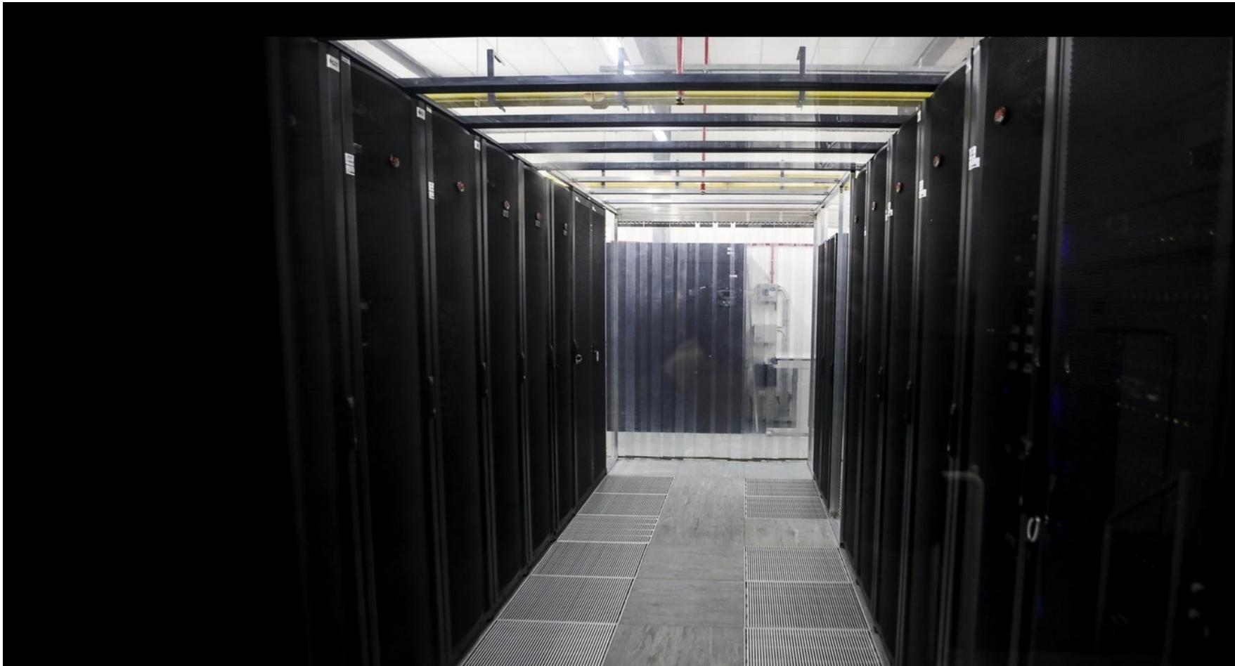
Sala Grid – Unidade FCCN -FCT (pormenor)
